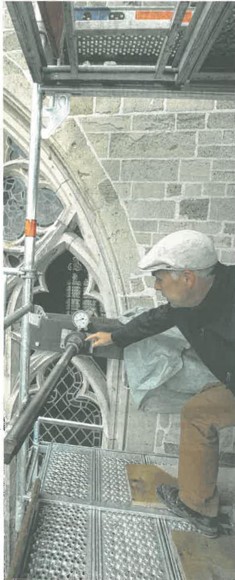
Johannes Schubert überprüft die Spannung der Zugseile.
