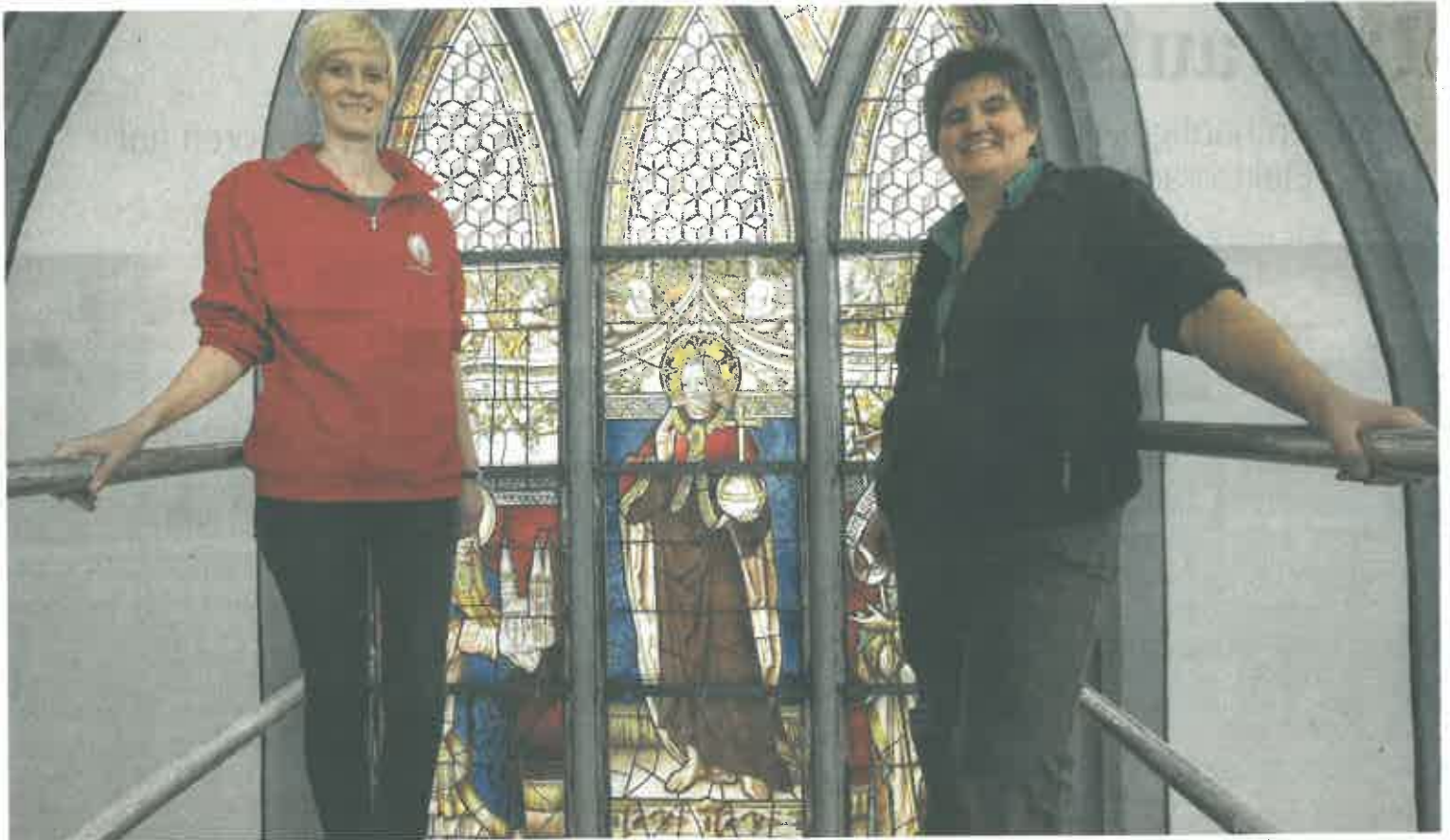
Diplom-Restauratorin Gerlinde Möhrle (rechts) und Franziska Koch von der Dombauhütte auf dem Gerüst vor dem nun vollendeten Salvatorfenster.
