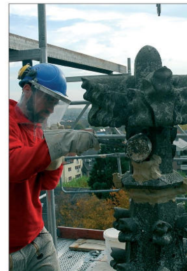
Matthias Dungs füllt die Fuge an der Kreuzblume mit flüssigem Blei aus.
