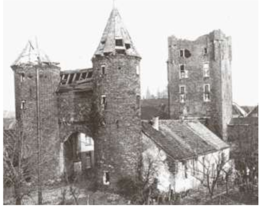
Schwer beschädigt: das Kleevers Tor.
